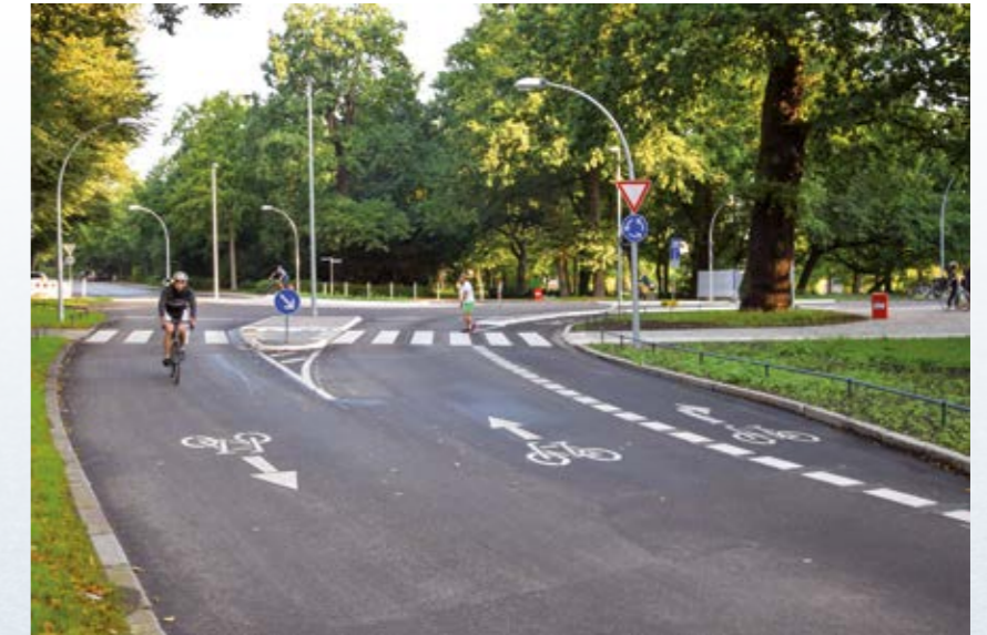
Fertiggestellte Fahrradstraße mit separater Abbiegespur.
