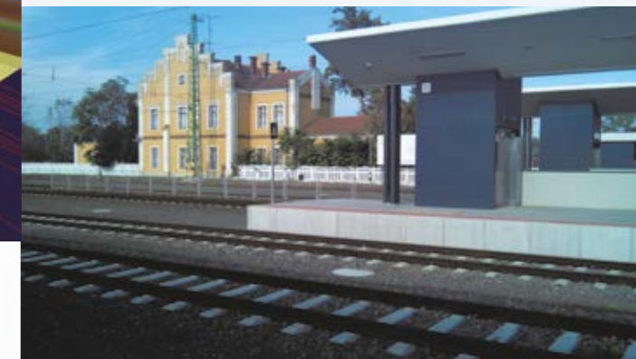
Inselbahnsteig zwischen zwei Gleisen in Törökszentmiklós.
